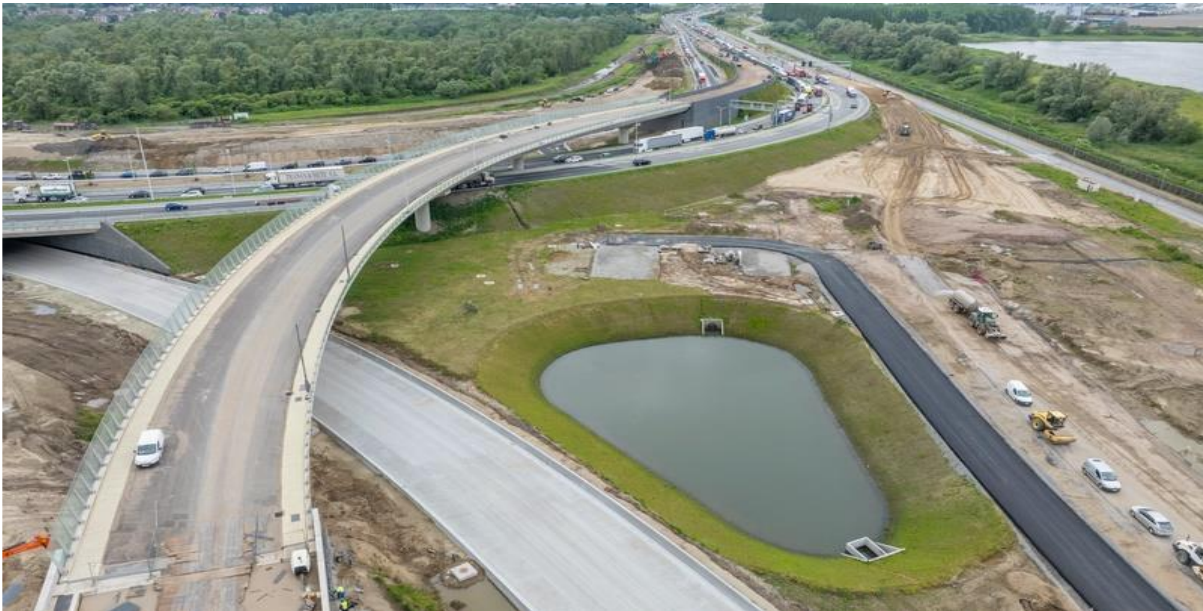
Brug van E34 naar nieuwe Scheldetunnel
