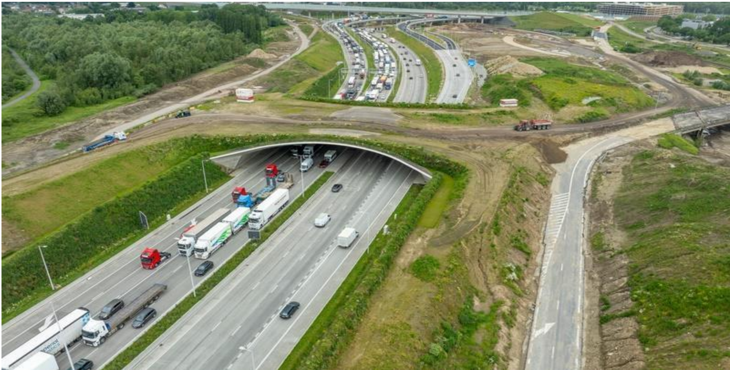
Ecobrug over R1 aan Kennedytunnel
